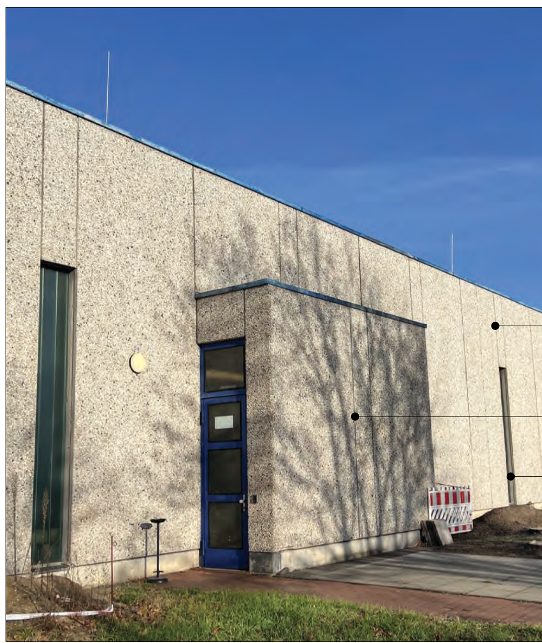
kontrollierter Rückbau Außenschale Beton sandwichkonstruktion Rückbau der Erker erst im Zuge der Hauptbaumaßnahme Rückbau Industriefenster und Öffnung ausbauen
